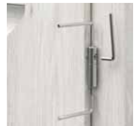
Триизмерно регулиране на цифтови шарнирни панци
